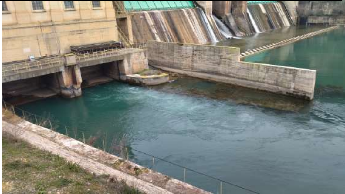
Figura 41. Central Camarasa_01 Vista detall del desguàs de les aigües
