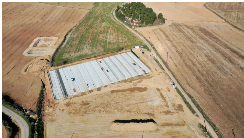
Vista aérea del espacio donde se debe desarrollar el Biohub Km0 de Alcarràs.
